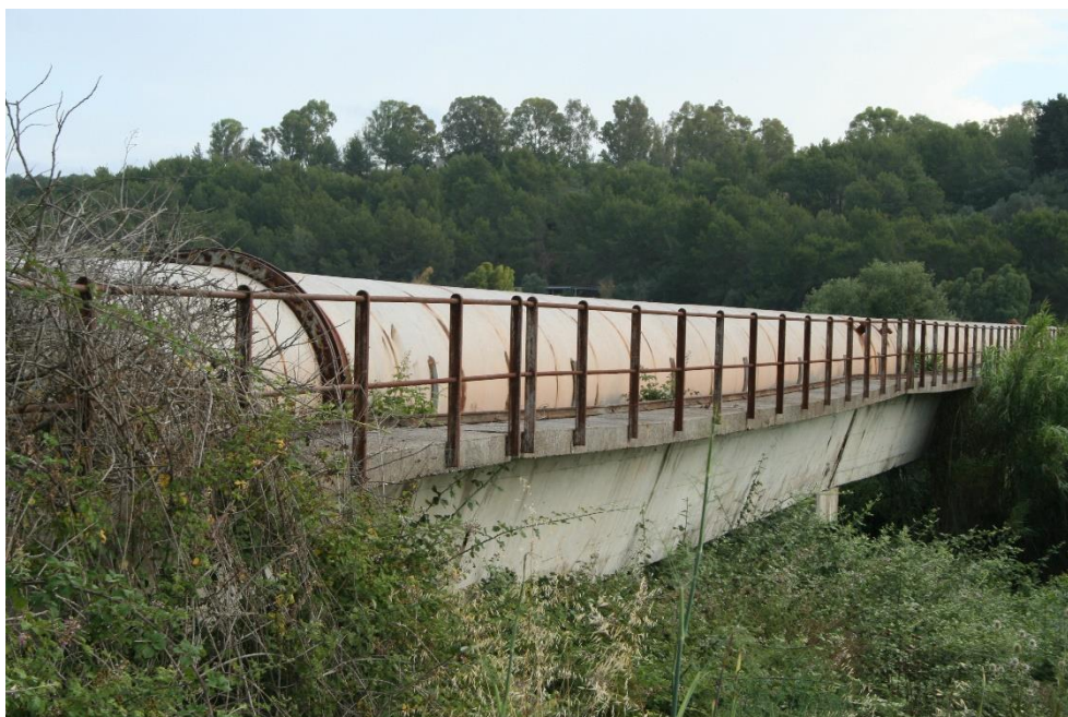
Evidenti segni di notevole freccia di inflessione su due campate
