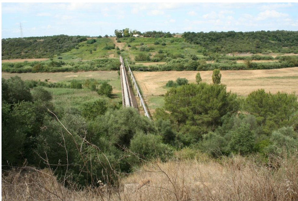
Vista d'assieme del Ponte-Tubo dal lato Castellaneta
