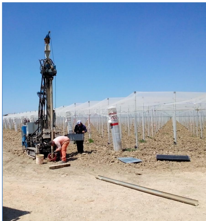
FIG. 9.C FASE DI ACQUISIZIONE SONDAGGIO S4
